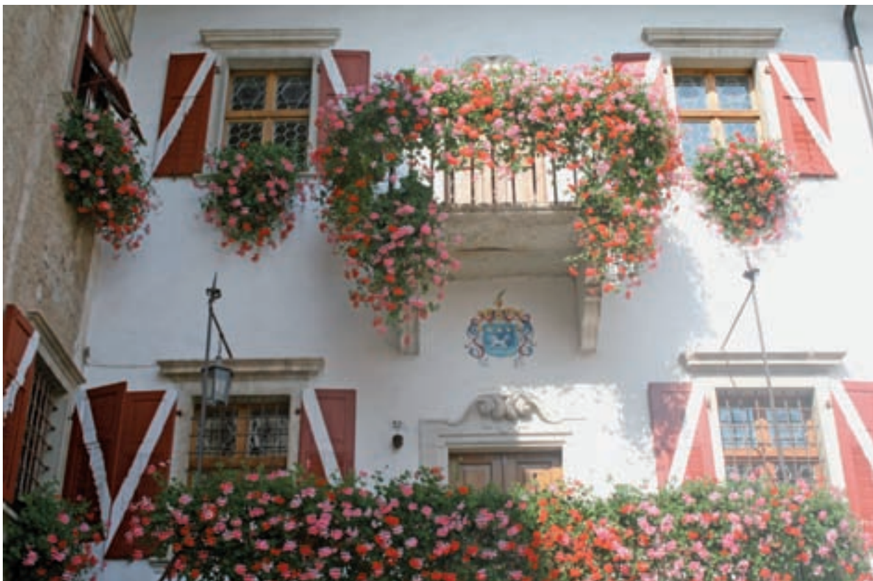
Castel Casez - Particolare della facciata.
