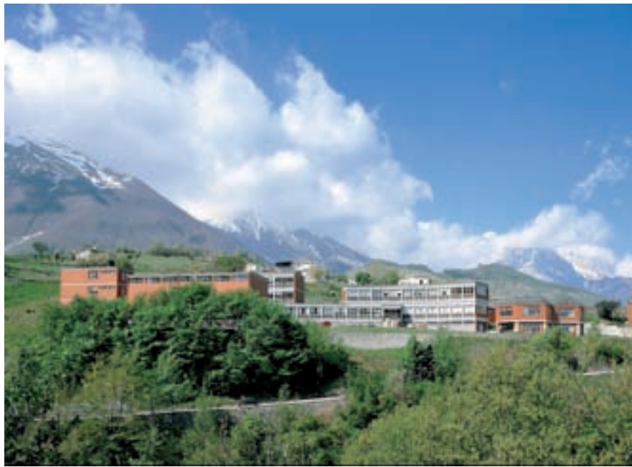
Una maestosa distesa di vette appenniniche (Gran Sasso d'Italia) si avvolge attorno al paesaggio che accoglie il moderno edificio dell'Istituto Statale d'Arte "F.A. Grue" di Castelli (TE), costruito negli anni 1966-70.
